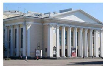
Капитальный ремонт драматического театра
