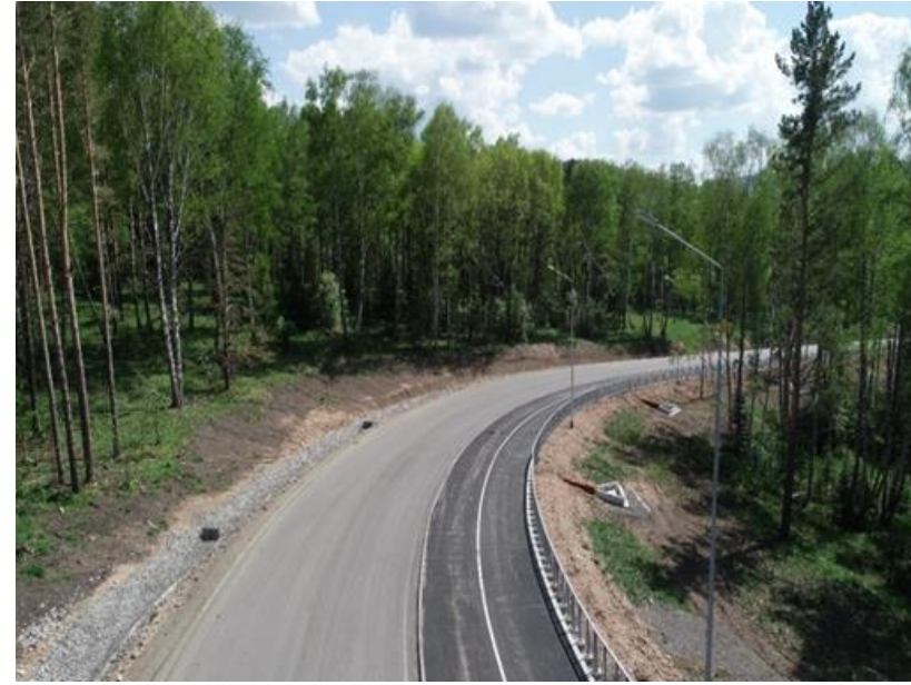
После строительства автомобильной дороги на «Белокурихе Горной».
