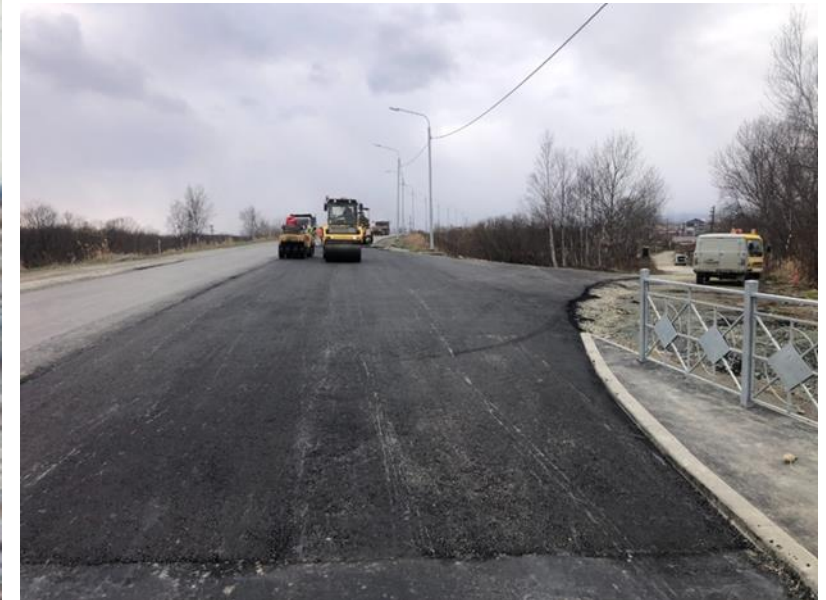
Ремонт дороги общего пользования межмуниципального значения Южно-Сахалинск – Оха.
