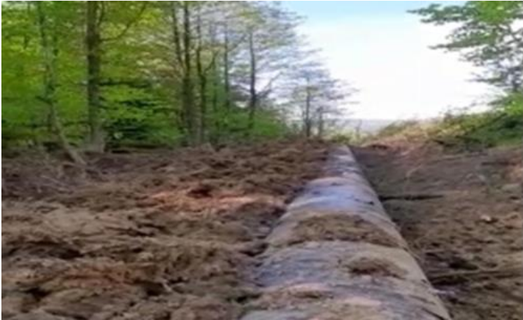
Старый магистральный водовод
