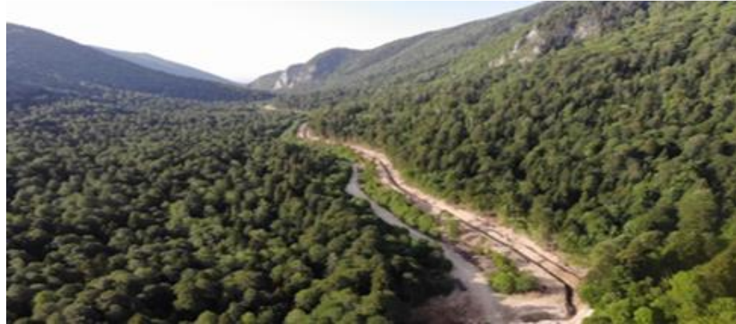
Новый магистральный водовод
