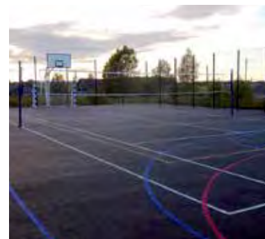
Устройство универсальной спортивной площадки Первомайского муниципального района, д. Игнатцево, Ярославская область
