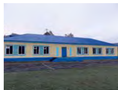
Ремонт кровли детско-юношеской спортивной школы, с. Солонешное Солонешенского района Алтайского края
