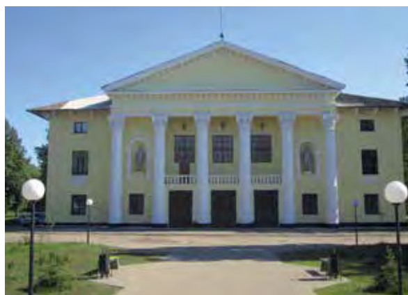
Ремонт Дома культуры и отдыха им. Молодцова, г. Донской, Тульская область
