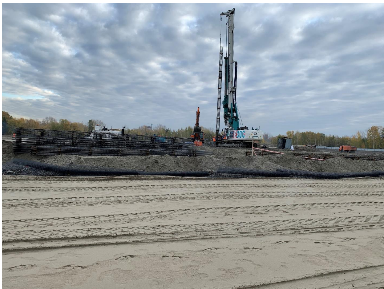
ГКУ НСО «Арена» (строительные работы)
