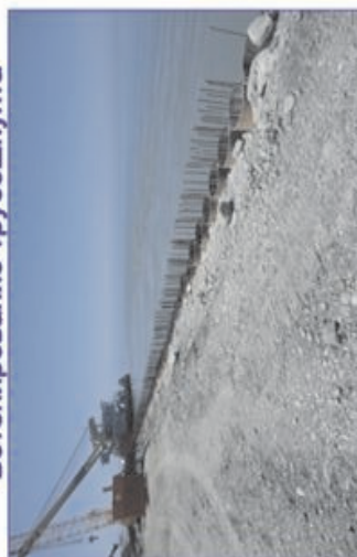
Бетонирование трубопунта
