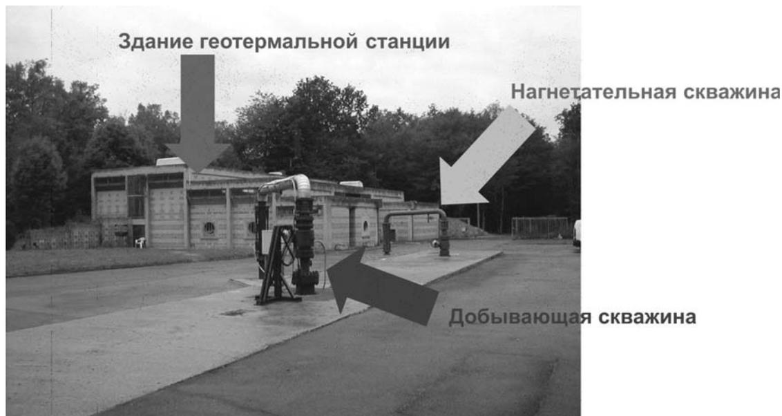
Рис. 1. Геотермальная станция в Парижском бассейне
