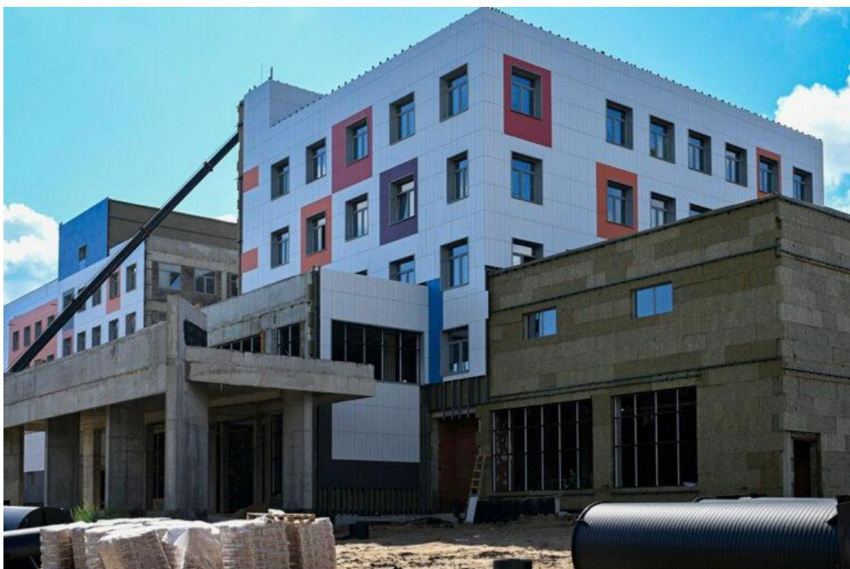
**2025** Ведутся работы по устройству кровли и фасада здания, монтажу внутренних перегородок, стяжки пола, оконных конструкций, а также внутренних инженерных систем и наружных сетей.
